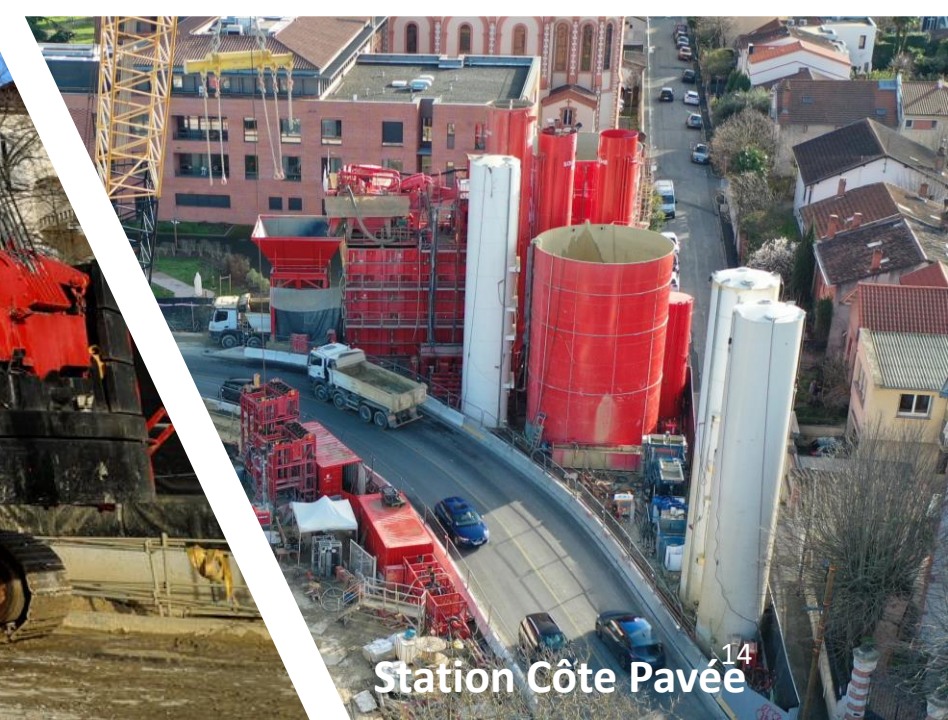
Station Limayrac – Cité de l'espace
